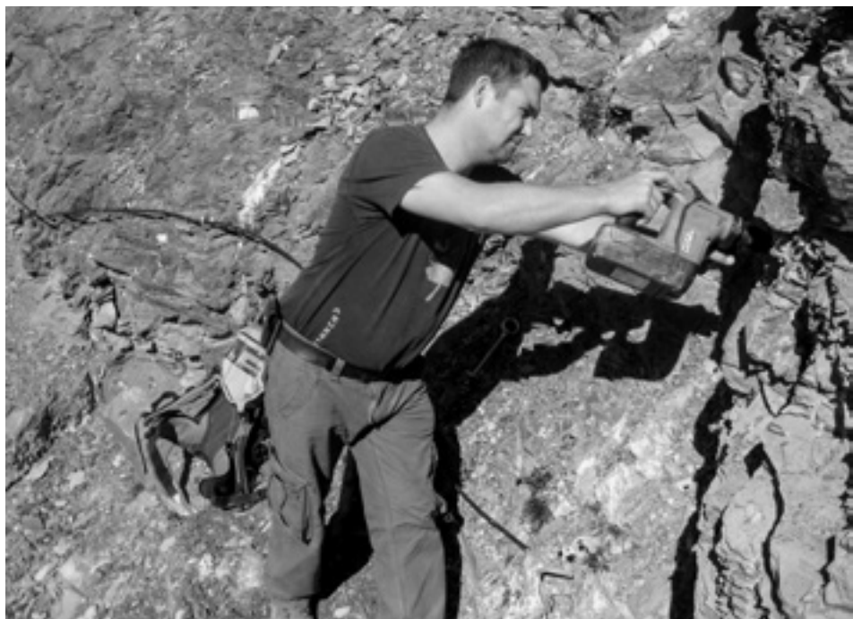
Dominik Frick beim Auswechseln eines Ankers (Sicherungsseil) auf der alpinen Route unterhalb des Falknis.
