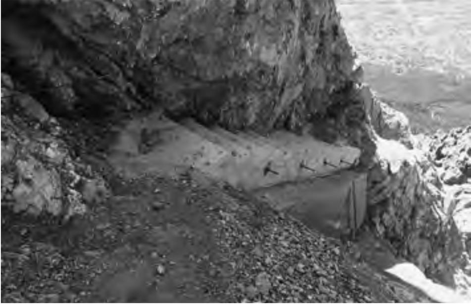
**Murgang beim Saasweg** Durch ein heftiges lokales Gewitter im August 2019 wurde der Saasweg im Bereich der Fluatola durch einen Murgang verschüttet. Für die aufwendigen Räumungsarbeiten musste ein Bagger eingesetzt werden, welcher den zugeschütteten Weg von mehreren Kubikmetern Kies befreite.
