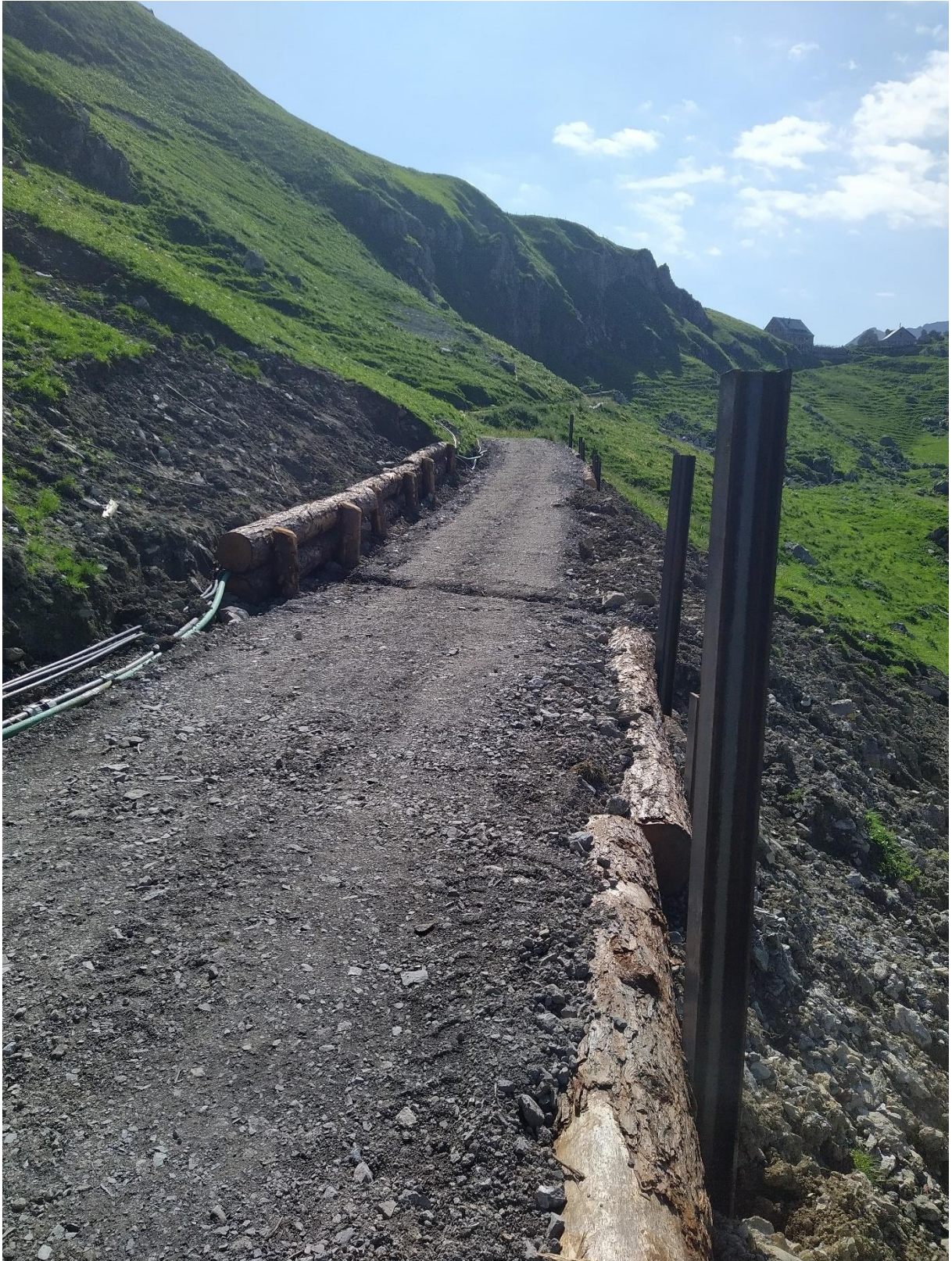
Strasse nach der Instandstellung Juni 2024
