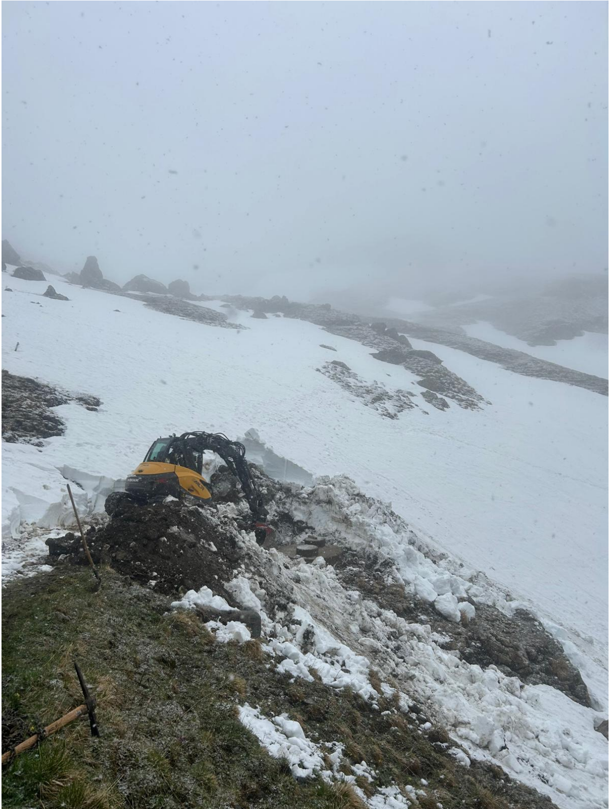
Sanierung Kläranlage, Schächte Nachklärung, Mai 2025
