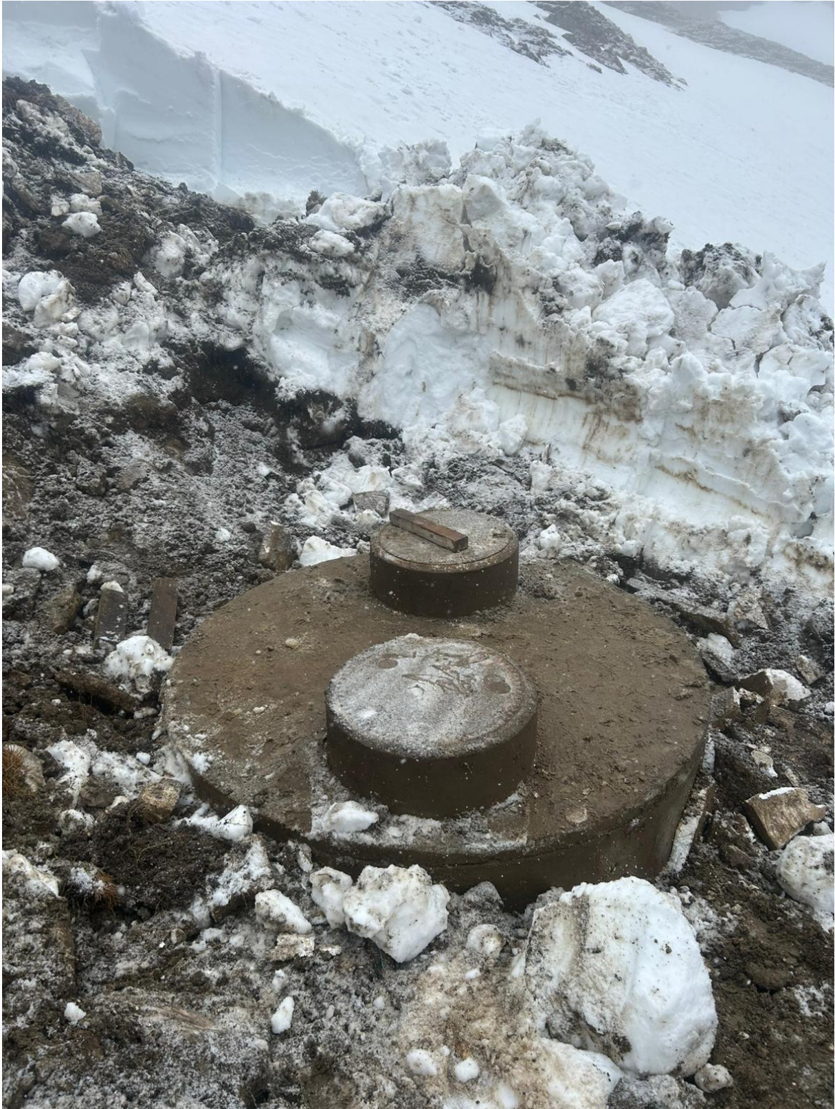
Freigrabung und Inbetriebnahme der Naafkopfquelle, Juni 2025
