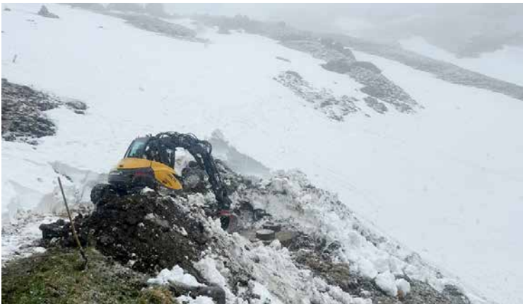
Freigrabung und Inbetriebnahme der Naafkopfquelle, Juni 2025
