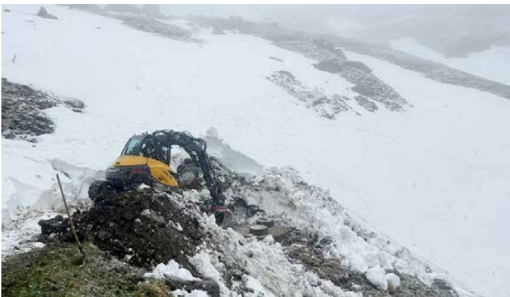
Freigrabung und Inbetriebnahme der Naafkopfquelle, Juni 2025
